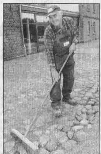
Letzter Schliff: Jürgen Martins von Gela Bau fegt die Steine ab.
